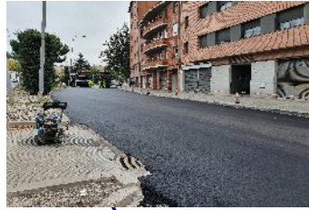
Asfaltatges dels carrers Prat de la Riba, Joan Llimona, J. Martí Franquesa i avinguda Gaudí
