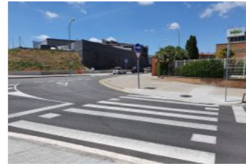
Asfaltatge dels carrers Carles Riba, Lecco i les avingudes de Catalunya i d'Andorra
