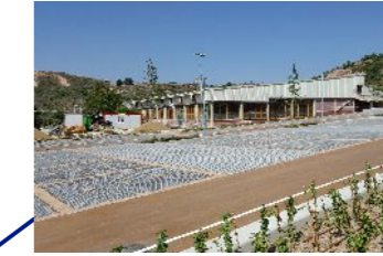
Nou aparcament gratuït de 135 places
