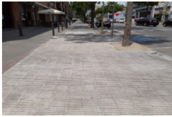
Millora de les voreres de l'avinguda Barcelona
